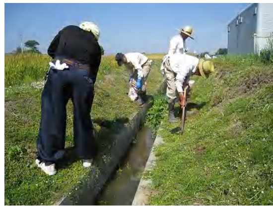
開水路の清掃
