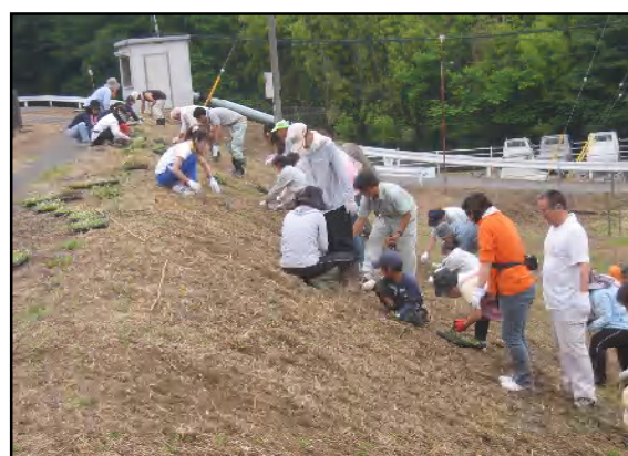
② ため池堤体への植栽
