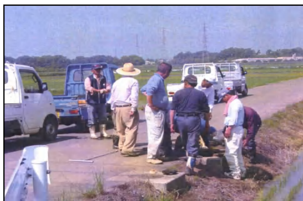
① 施設の点検・機能診断
